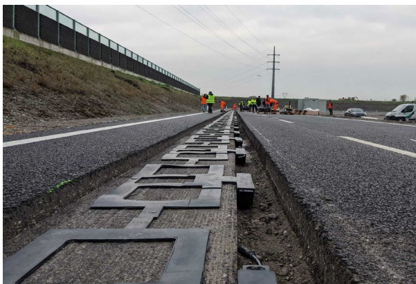
Рисунок 12 Установка медных катушек на обочине
